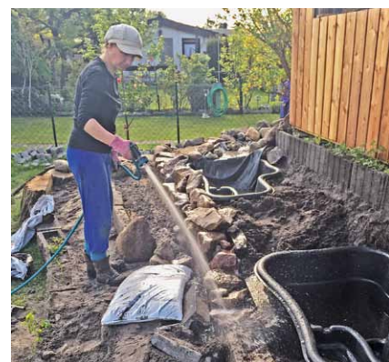
Ein Bachlauf entstand: Die beiden Teiche wurden durch ein Bachbett mit Gefälle verbunden, sodass im Falle eines Starkregens eine natürliche Fließsituation entsteht.
